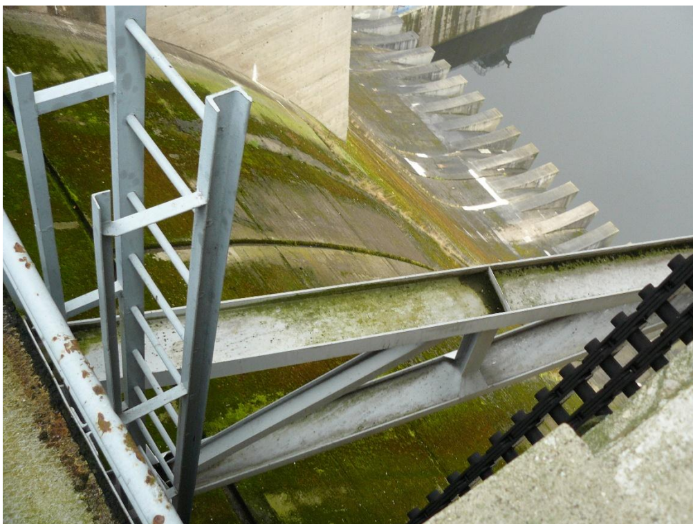
Foto č. 4 – Pohled na přeliv s ramenem segmentového uzávěru
