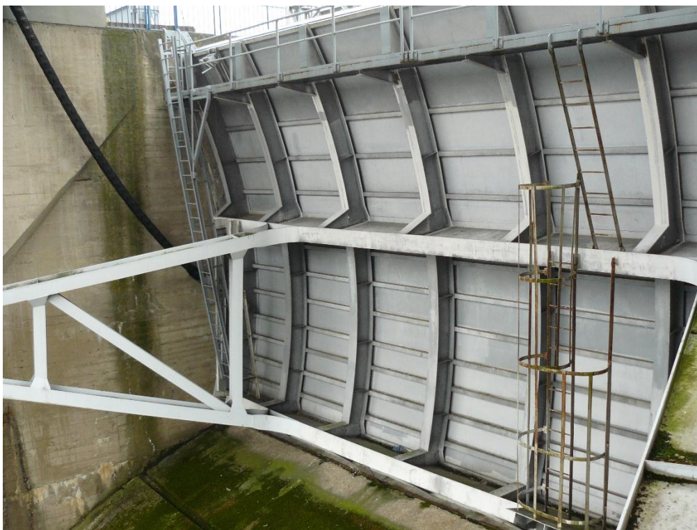
Foto č. 1 – Pohled na segmentový uzávěr proti vodě s detailem žebříku
