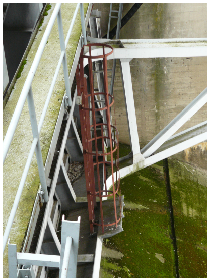
středový ocelový žebřík bude nahrazen novým nerezovým
